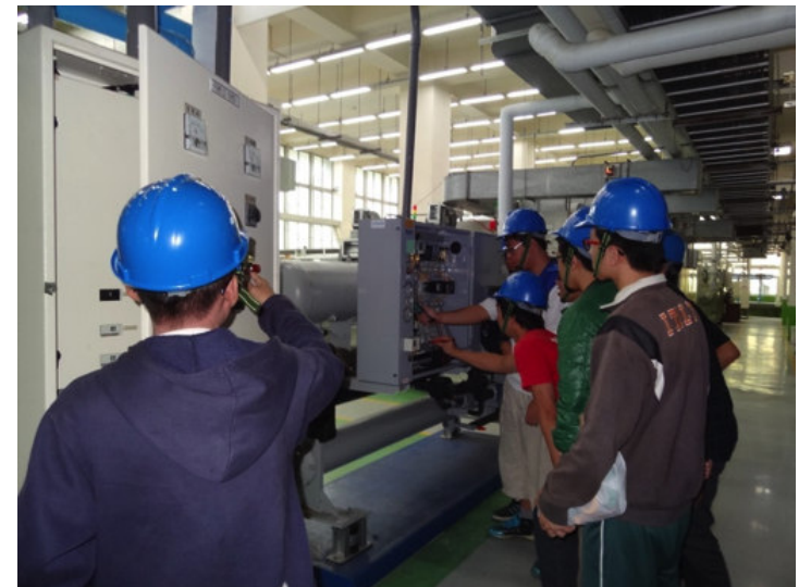
▲冷凍空調節能班訓練實況。
